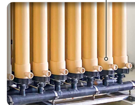
Modules membranaires à fibres creuses
