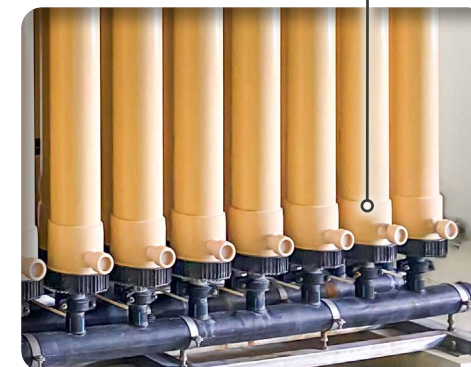
Modules membranaires à fibres creuses
